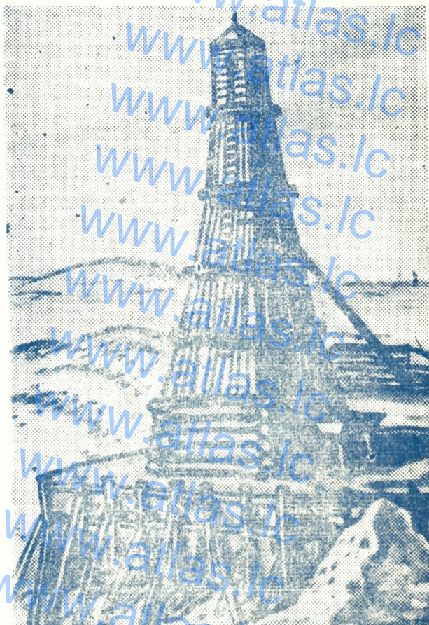
Такие деревянные вышки применялись на буровых Эмбы в дореволюционное время
